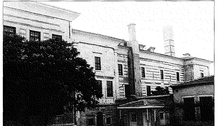
Darphâne-i Âmire binası - İstanbul
